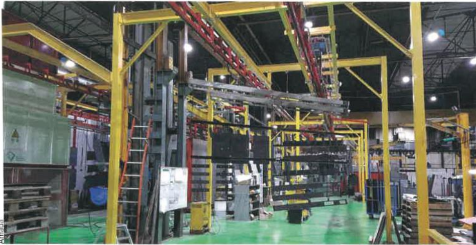
Une vue de la ligne de poudrage chez Amada.
